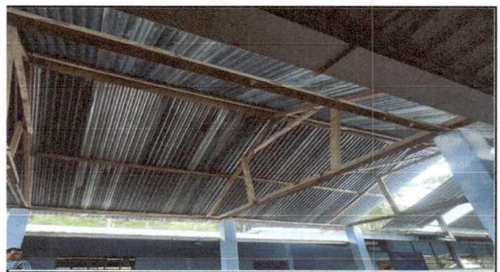
Foto 4: Cambio de estructura de techo y laminas, interior.
