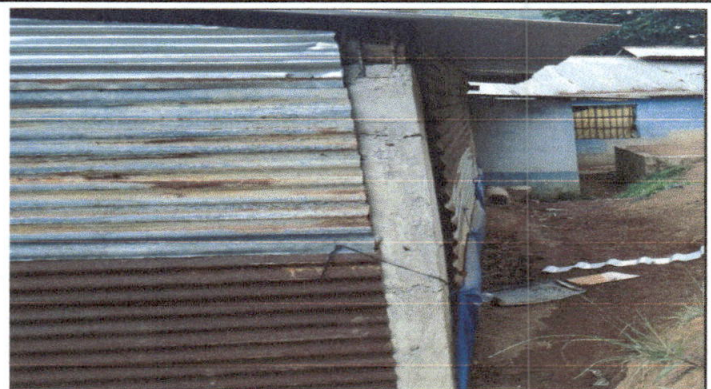
Foto 2: Cambio de techo en edificio de cocina.
