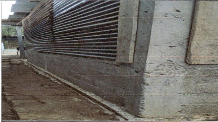
Foto 1: Mejora y remodelación de edificio para cocina. Culminación de paredes en todas las áreas del edificio y repello de las paredes.
